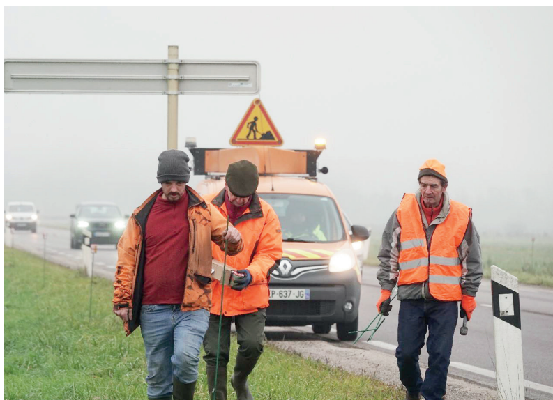
Mise en place des piquets à la Chapelle-lès-Luxeuil
